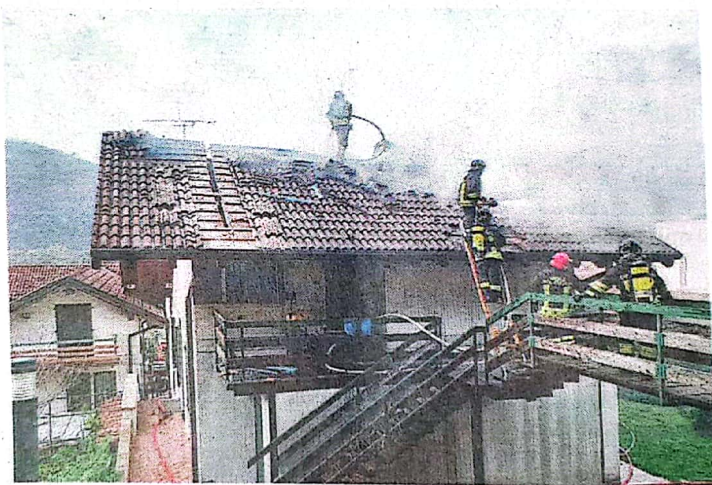
Copertura. Vigili del fuoco sul tetto dell'abitazione
