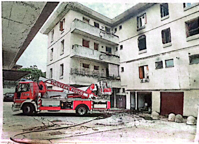
Via Silvio Pellico. L'intervento dei Vvff per spegnere l'incendio scoppiato al primo piano. // FOTO NEG ORTOGNI
